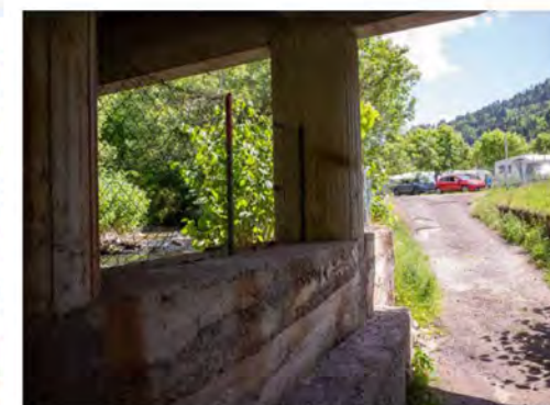
SITE N° 4 : PASSAGE SOUS LA GARE + PARVIS
