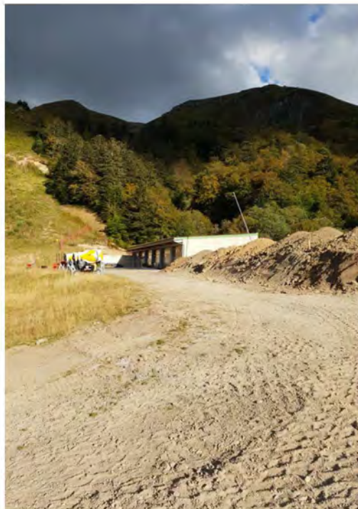
SITE N° 2 : HANGAR À DAMEUSES
