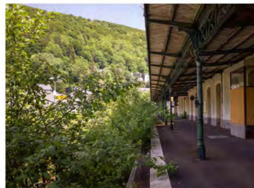
SITE N° 7 : BÂTIMENT DE LA GARE
