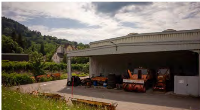
SITE N° 1 : ZONE D'ACTIVITÉ (DÉPÔT DDT)
