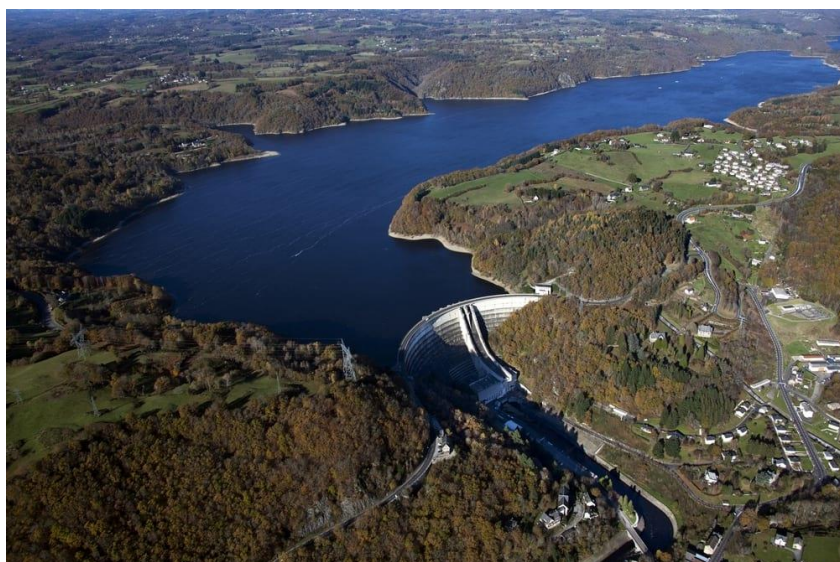
Barrage de Bort-les-Orgues (Source : EDF)
